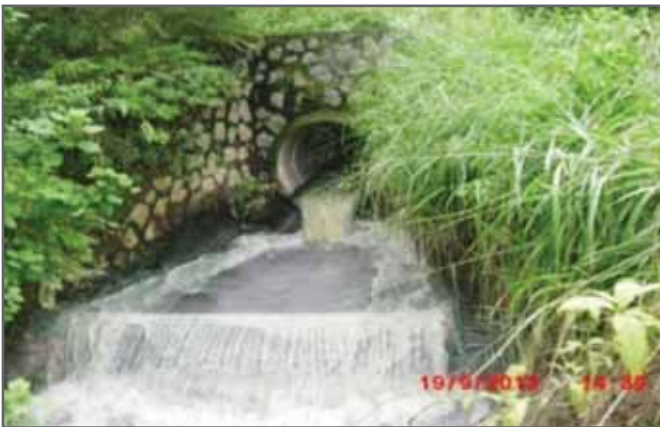
Vertido de aguas residuales del casco urbano de San Miguel sin tratamiento
