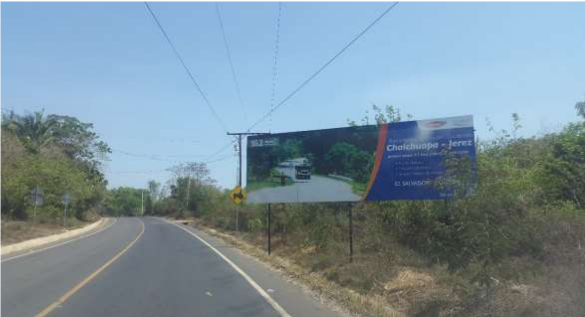
Imagen 4. Inicio de camino rehabilitado (1ra Etapa). Tramo Chalchuapa- Jerez.
