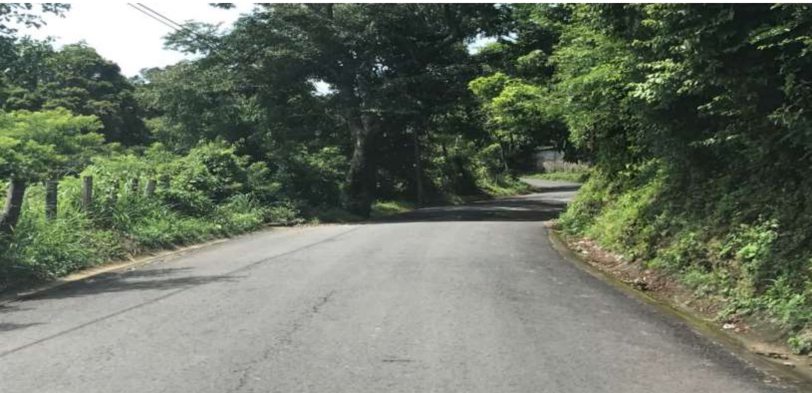
FOTOGRAFÍA / TRAMO DE CARRETERA QUE CONDUCE DESDE EL MUNICIPIO DE SAN MIGUEL DE MERCEDES A LOS MUNICIPIOS DE SAN ANTONIO LOS RANCHOS Y POTONICO.
